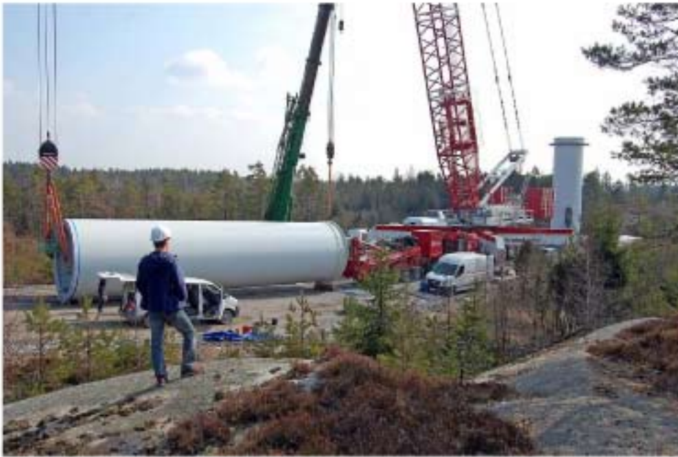
Figur 3: Exempel på monteringsyta för vindkraftverk Källa: E.ON Vind
