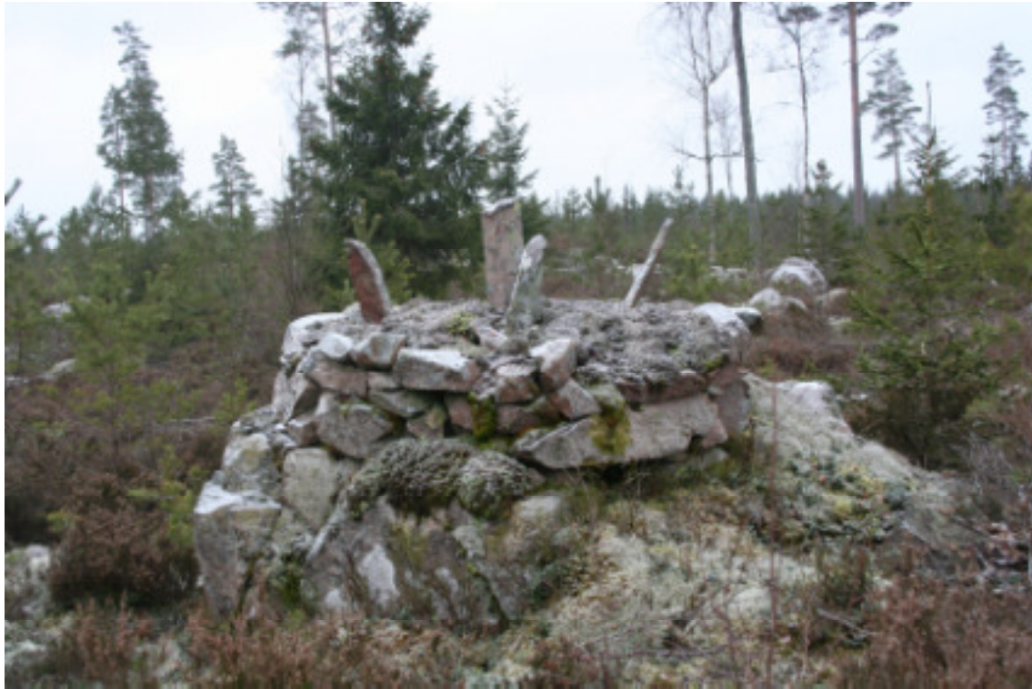
Algutsboda 473. Gränsmärket anlades i samband med en rågångsbestämning år 1788 och ligger fortfarande kvar i gränsen mellan Algutsboda och Hälleberga socknar. Bild mot söder.
