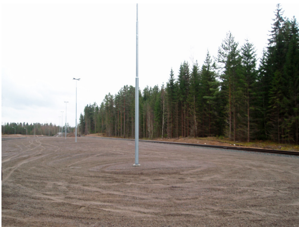
Den grusade ytan mellan de två spåren som utgör "Östra industrispåret"
